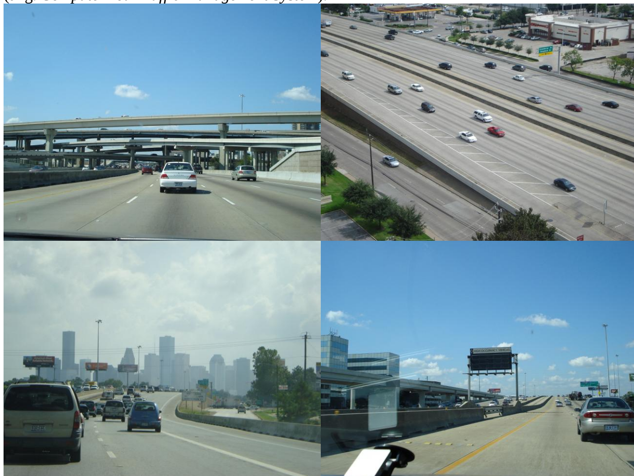
Foto 3. Rozbudowana infrastruktura drogowa na obszarze metropolitalnym Houston. Na prawym dolnym zdjęciu widoczny znak o zmiennej treści.
